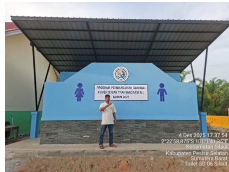
Gambar 3.1 Rehab Toilet Sekolah
