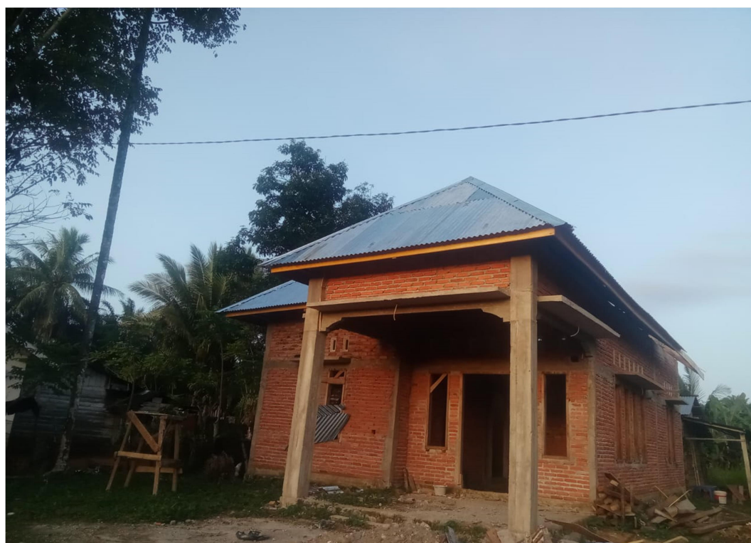
Gambar 3.9 : Kondisi Rumah Layak Huni (Setelah dilakukan Rehabilitasi)
