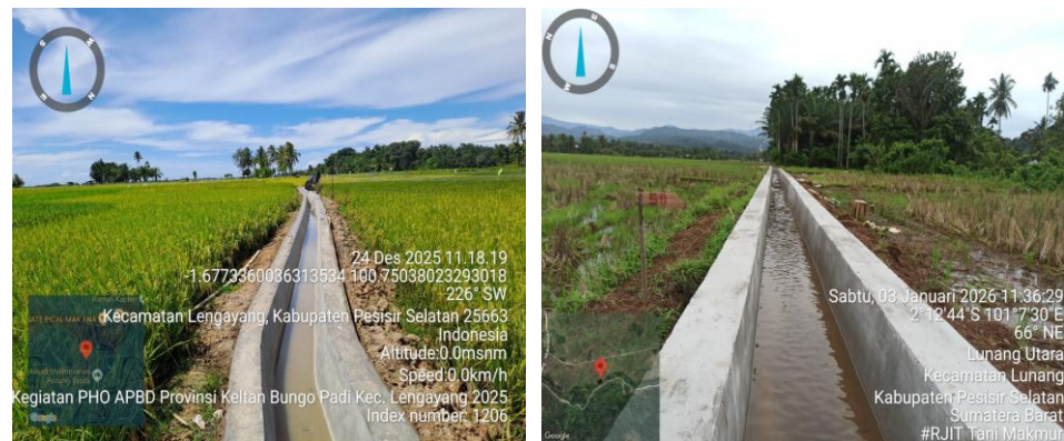
Gambar 3.21 : Rehabilitasi Jaringan Irigasi Tersier Tahun 2025
