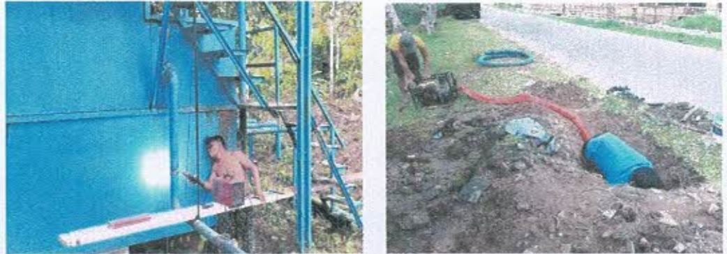
Gambar 3. 2 Perbaikan outlet Bak WTP dan perbaikan jaringan perpipaa distribusi Tahun 2025 di Nagari Sakato Kec. Batang Kapas
