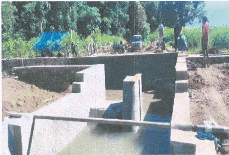
Gambar 3. 6 Rehabilitasi Jaringan Irigasi DI. Banda Panjang
