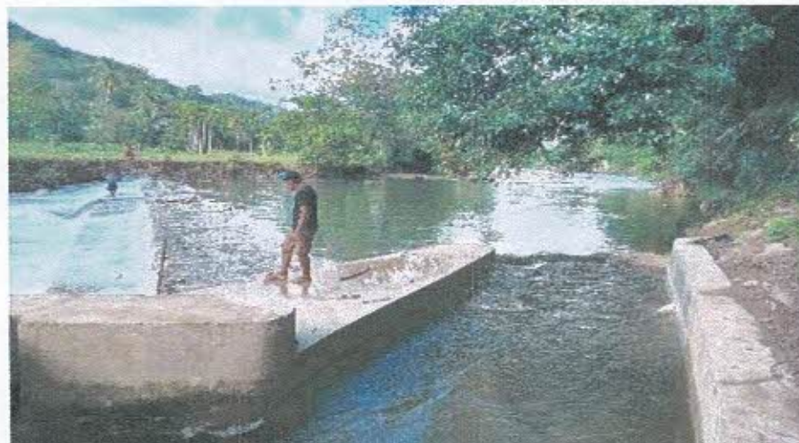
bar 3. 7 Rehabilitasi Jaringan Irigasi DI. Ambacang
