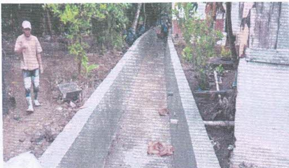
Gambar 3. 5 Rehabilitasi Jaringan Irigasi DI. Talang Ketaping
