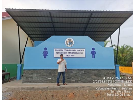
Gambar 3.1 Rehab Toilet Sekolah
