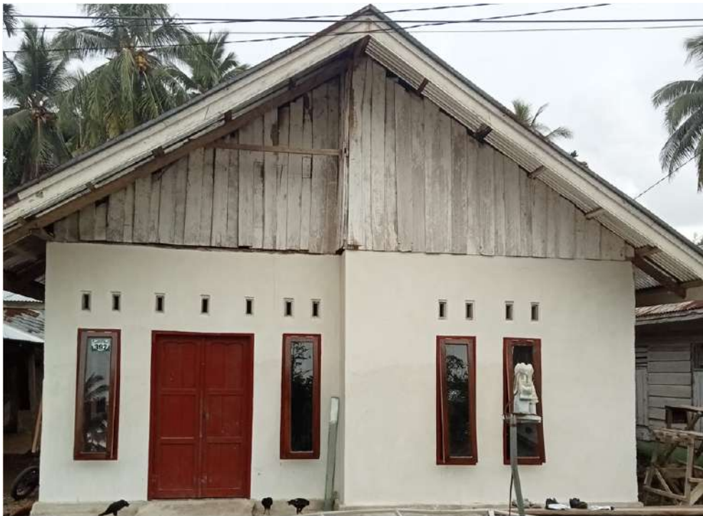
Gambar 3.10 : Kondisi Rumah Layak Huni (Setelah dilakukan Rehabilitasi)
