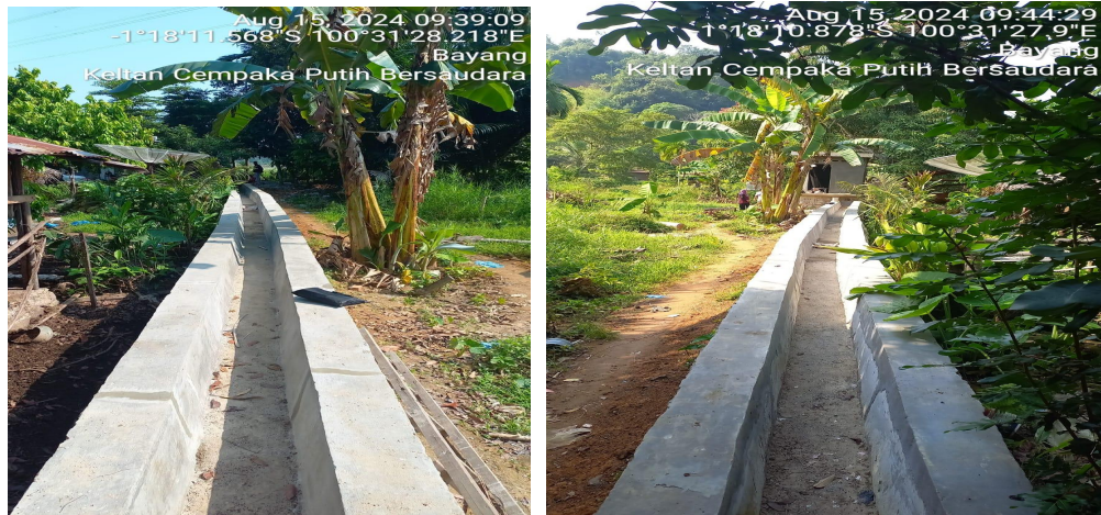
Gambar 3.20 : Rehabilitasi Jaringan Irigasi Tersier Tahun 2024
