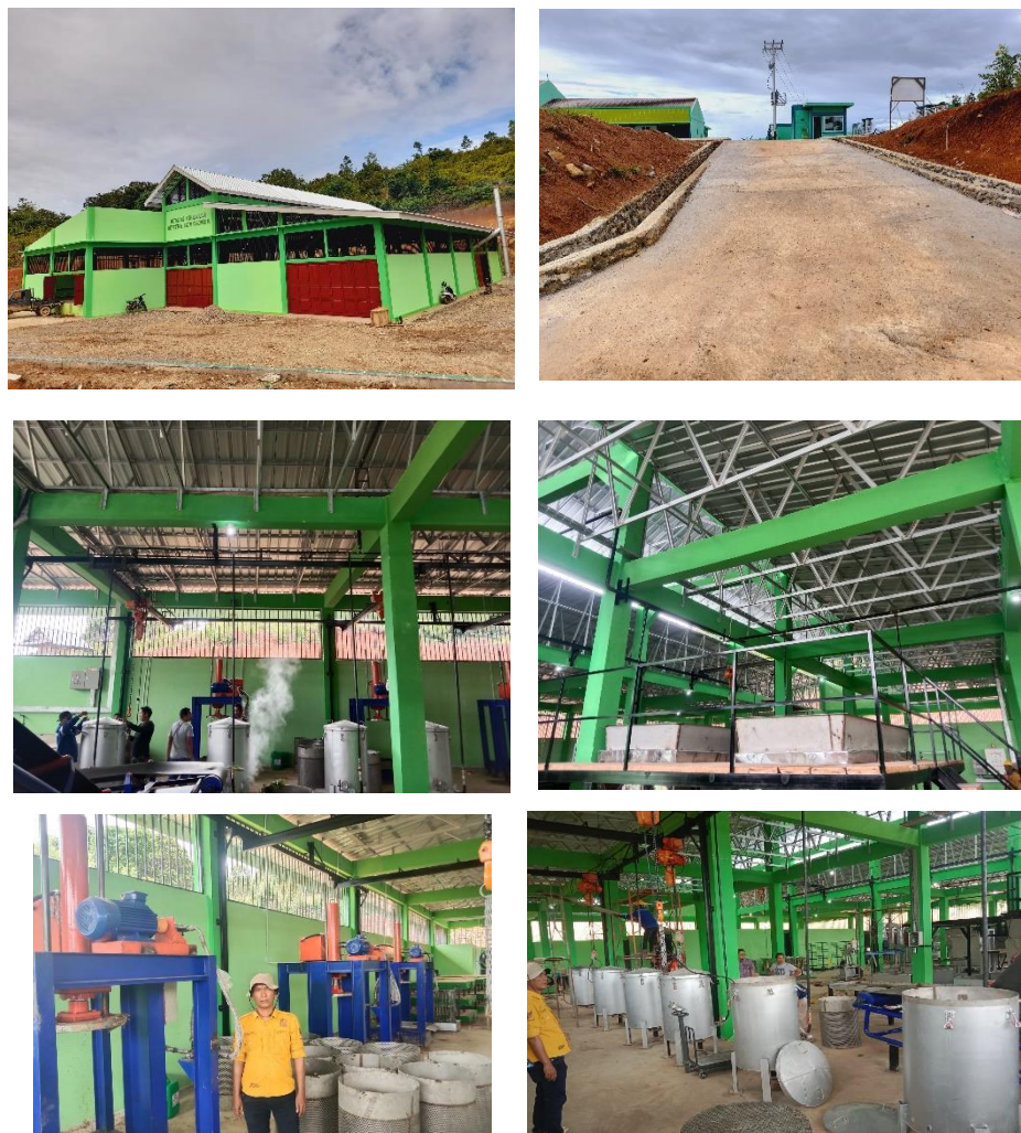
Gambar 3.22 Dokumentasi Pembangunan Sentra IKM Gambir di Kecamatan Sutera
