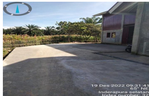
Pembangunan Lantai Jemur
