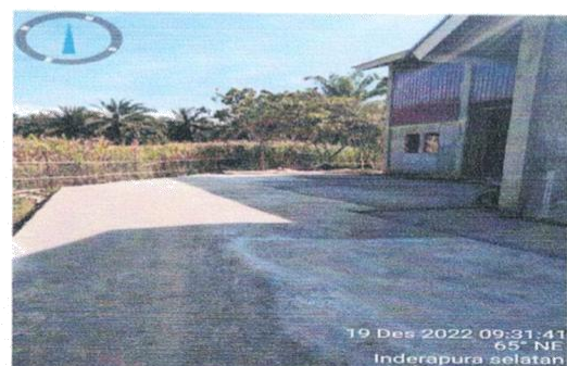
Pembangunan Lantai Jemur
