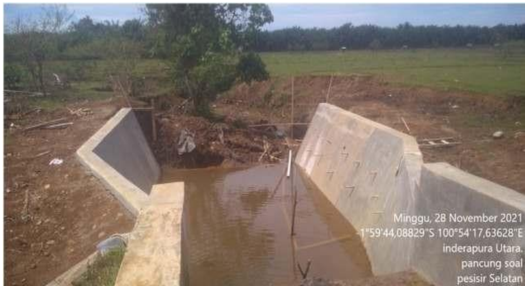
Gambar 2.15. Perbaikan Sayap Bendung Daerah Irigasi (DI) Damar Rumpit
