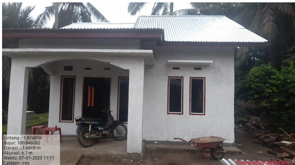
Rumah Layak Huni (Setelah di rehabilitasi)
