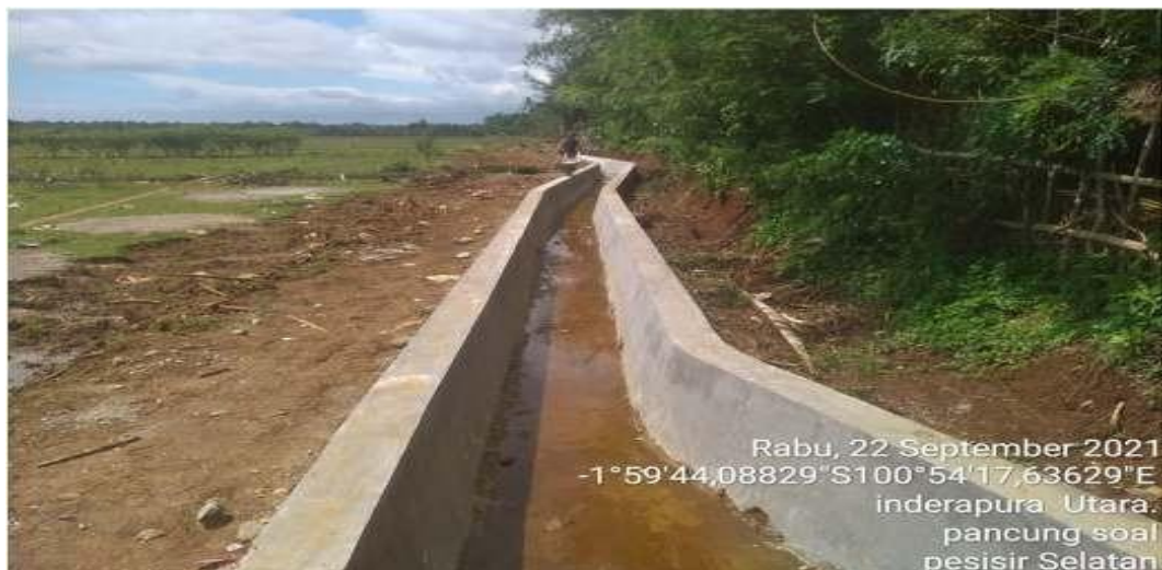
Gambar 2.16 Rehabilitasi Saluran DI Damar Rumpit
