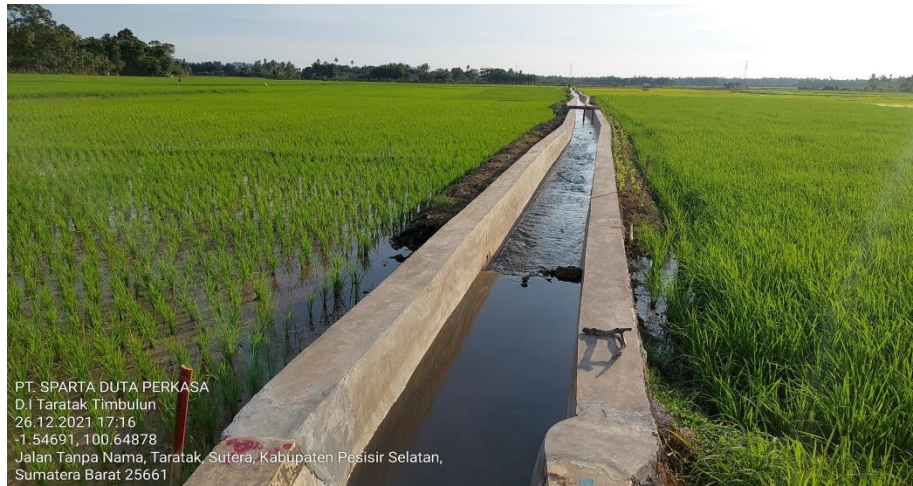
Gambar 2.9 : Bendung DI. Koto Panjang (2021 )
