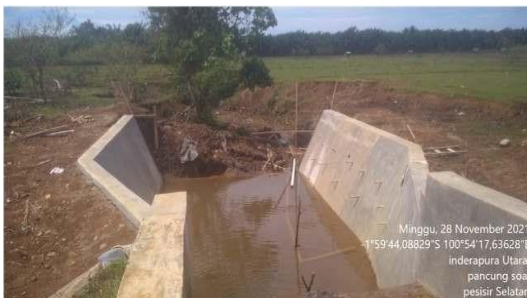
Gambar 2.13 : Perbaikan Sayap Bendung Daerah Irigasi (DI) Damar Rumput
