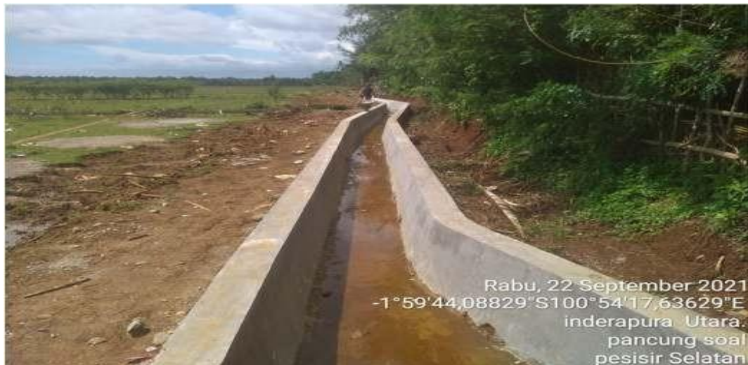
Gambar 2.14 : Rehabilitasi Saluran DI Damar Rumpit
