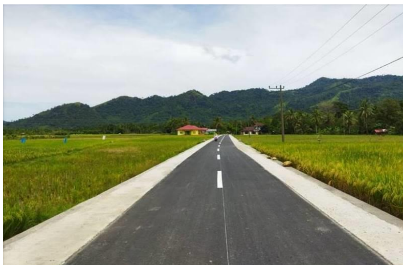
Gambar 2.7 : Peningkatan Jalan Cumateh – Kampung Sawah, Kec. Koto XI Tarusan Tahun 2021
