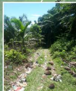
5. Jalan Tanah Rusak
