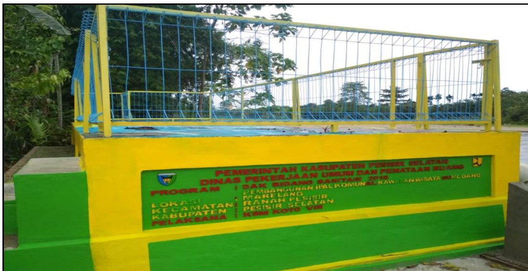
Pembangunan Bak IPALD Lokasi Nagari Koto VIII Pelangai Kec. Ranah Pesisir Tahun 2018
