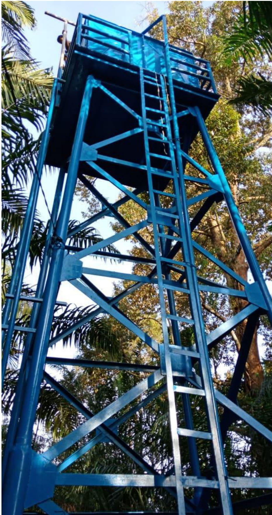
Pembangunan SPAM JP Silaut di Kec. Silaut Tahun 2018
