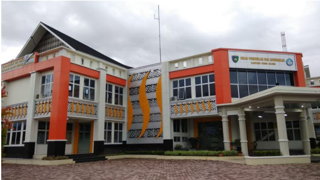
Pembangunan Gedung Dinas Pendidikan dan Kebudayaan Kec. IV Jurai Tahun 2018
