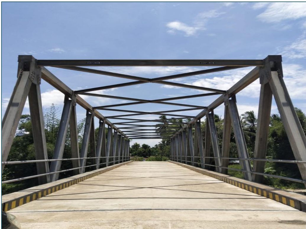
Pembangunan Jembatan Nyiur Gading Kec.Lengayang Tahun 2018
