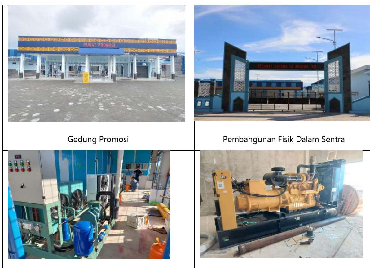
Gambar 3.7 Pembangunan Sentra IKM tahap III
