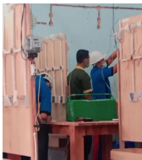
Gambar 3.6 Pelatihan Teknik Listrik (Pemasangan Instalasi Listrik Bangunan Sederhana) 2 09 Juli s/d 24 Agustus 2021
