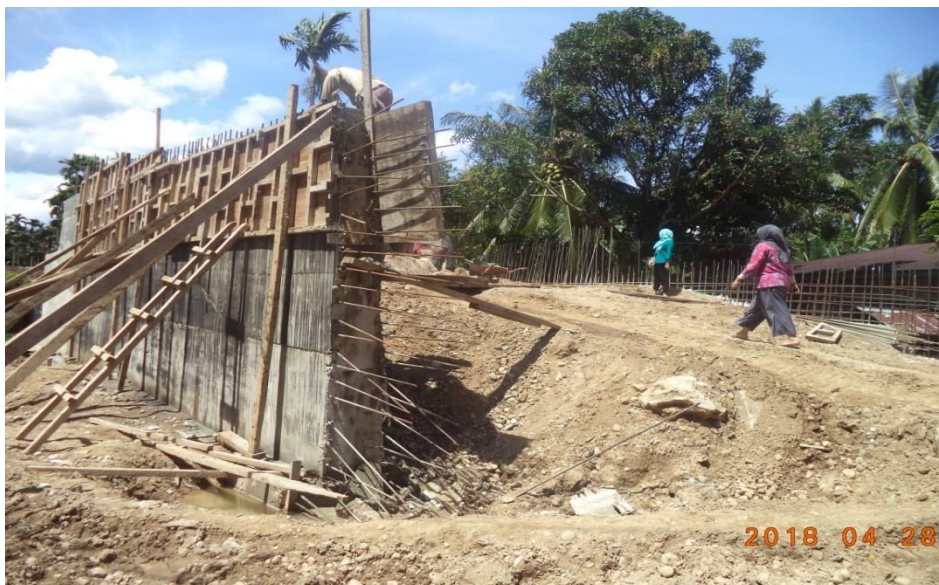
*Pelaksanaan Pembangunan Jembatan Jembatan Nyiur Gading
