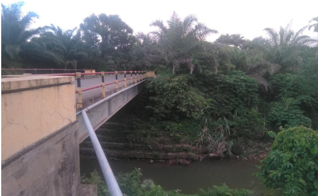
Pemasangan Pipa Distribusi Air Minum Sindang (2018)
