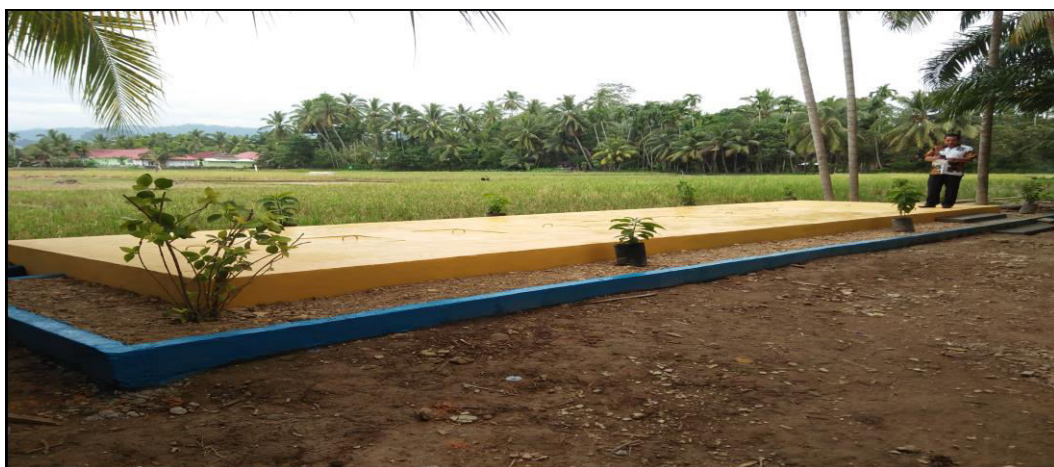
Bangunan IPAL Komunal Tahun 2017
