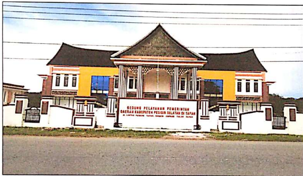
Pembangunan Kantor Pelayanan PEMDA di Tapan Tahun 2020
