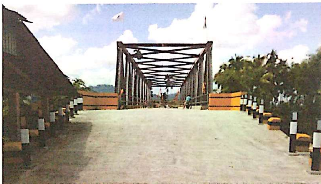
Pembangunan Jembatan Rangka Binjai (Lanjutan) Kec. Ranah Ampek Hulu Tapan Tahun 2020
