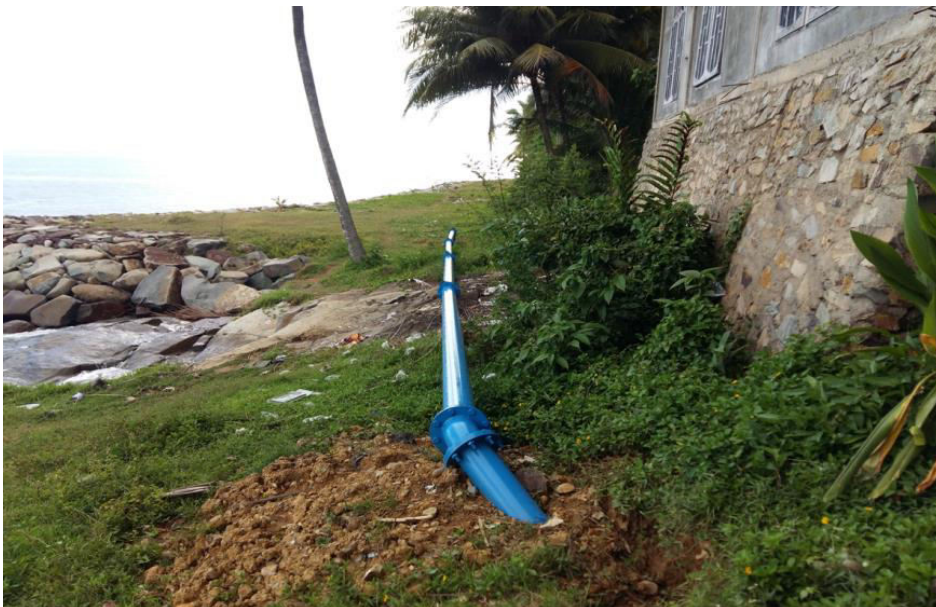
Pemasangan Pipa Distribusi Air Minum Luhung Pasar Baru (2017)
