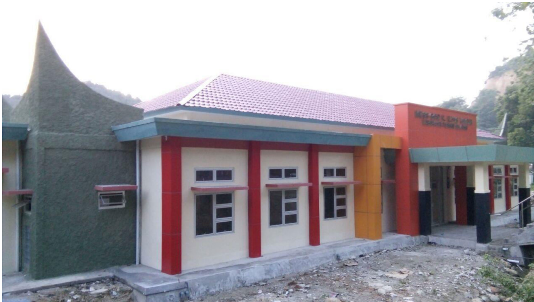
Pembangunan Gedung Mess Gor H. Ilyas Yakub Painan
