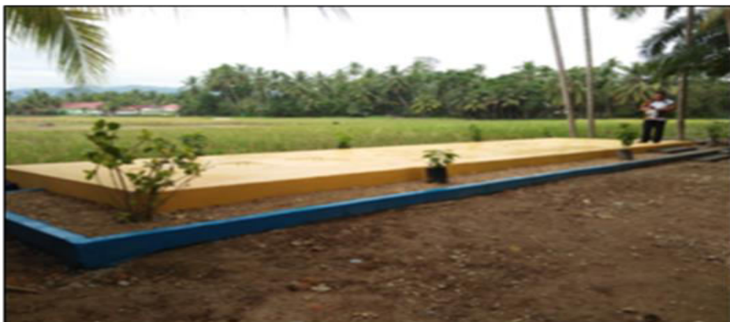
Bangunan IPAL Komunal Tahun 2017
