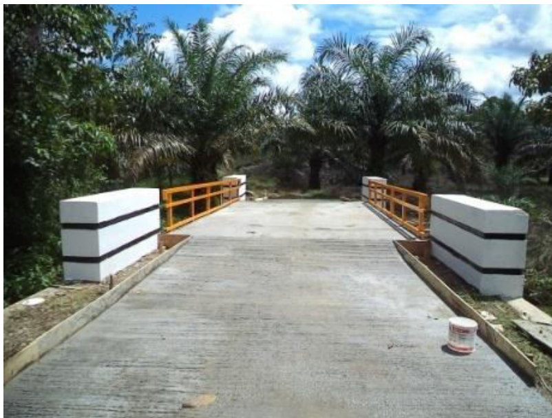
Pelaksanaan Rehabilitasi Jembatan
