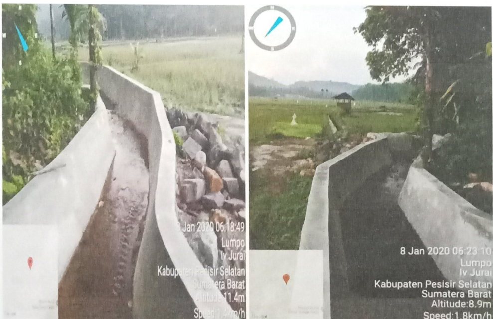
Gambar 2 : Rehabilitasi Jaringan Irigasi Tersier Di Kecamatan IV. Jurai Kab. Pessel
