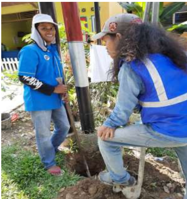
Pemasangan Tiang Fiber Optic
