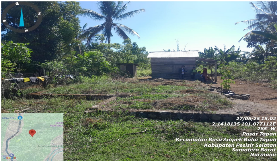
Gambar 3.9 : Kondisi Rumah Tidak Layak Huni (Sebelum dilakukan Rehabilitasi)
