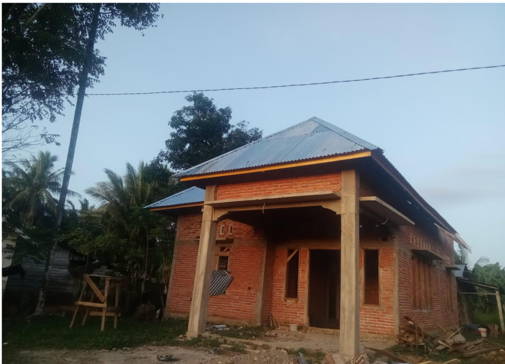
Gambar 3.10 : Kondisi Rumah Layak Huni (Setelah dilakukan Rehabilitasi)
